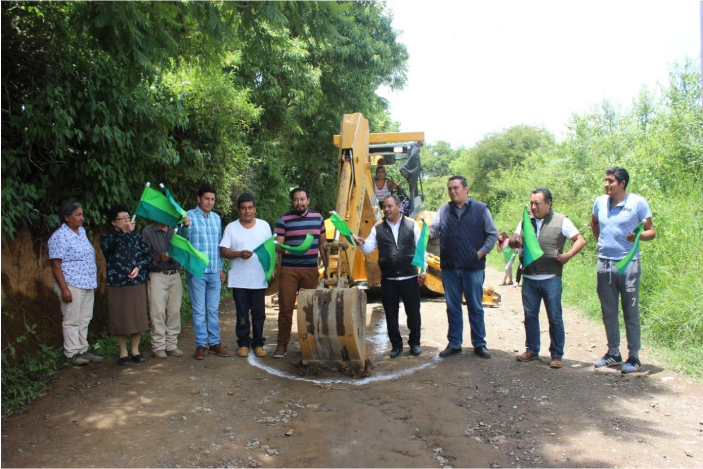
Construcción de red de Drenaje, calle Tlacuazingo, Cabecera OCUITUCO
