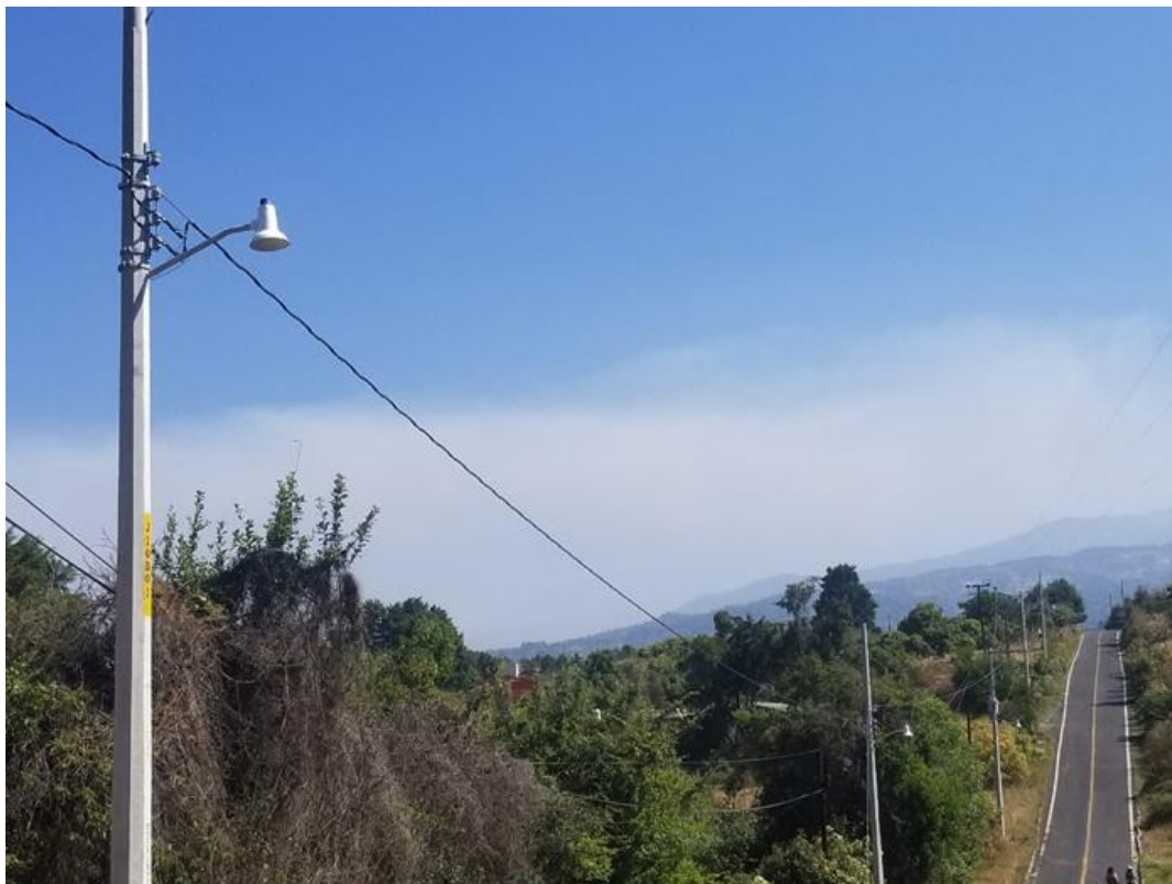
Ampliación de red eléctrica en calle Nueva Libertad, de la Comunidad de OCOXALTEPEC
