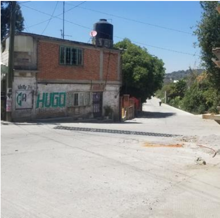
Construcción de red de drenaje pluvial en la calle buena suerte, de la comunidad de METEPEC
