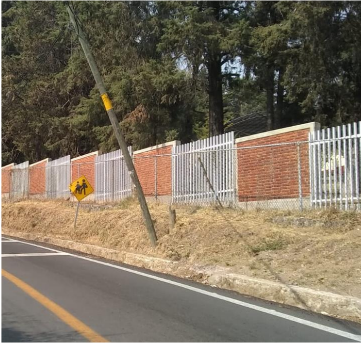
Construcción de barda perimetral en la escuela Primaria Agustín Cazares, de JUMILTEPEC
