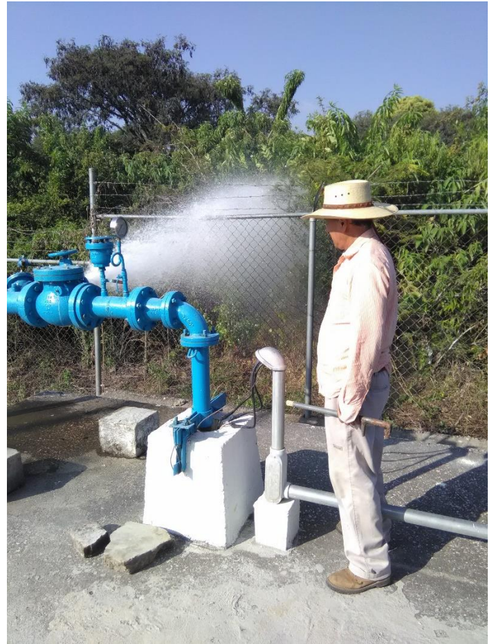
Trabajos de mantenimiento preventivo- correctivo a los arrancadores en el Pozo Coayuca de JUMILTEPEC
