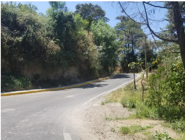
Construcción de banqueta en el paraje conocido como el Plan hacia el centro de la comunidad de HUEJOTENGO
