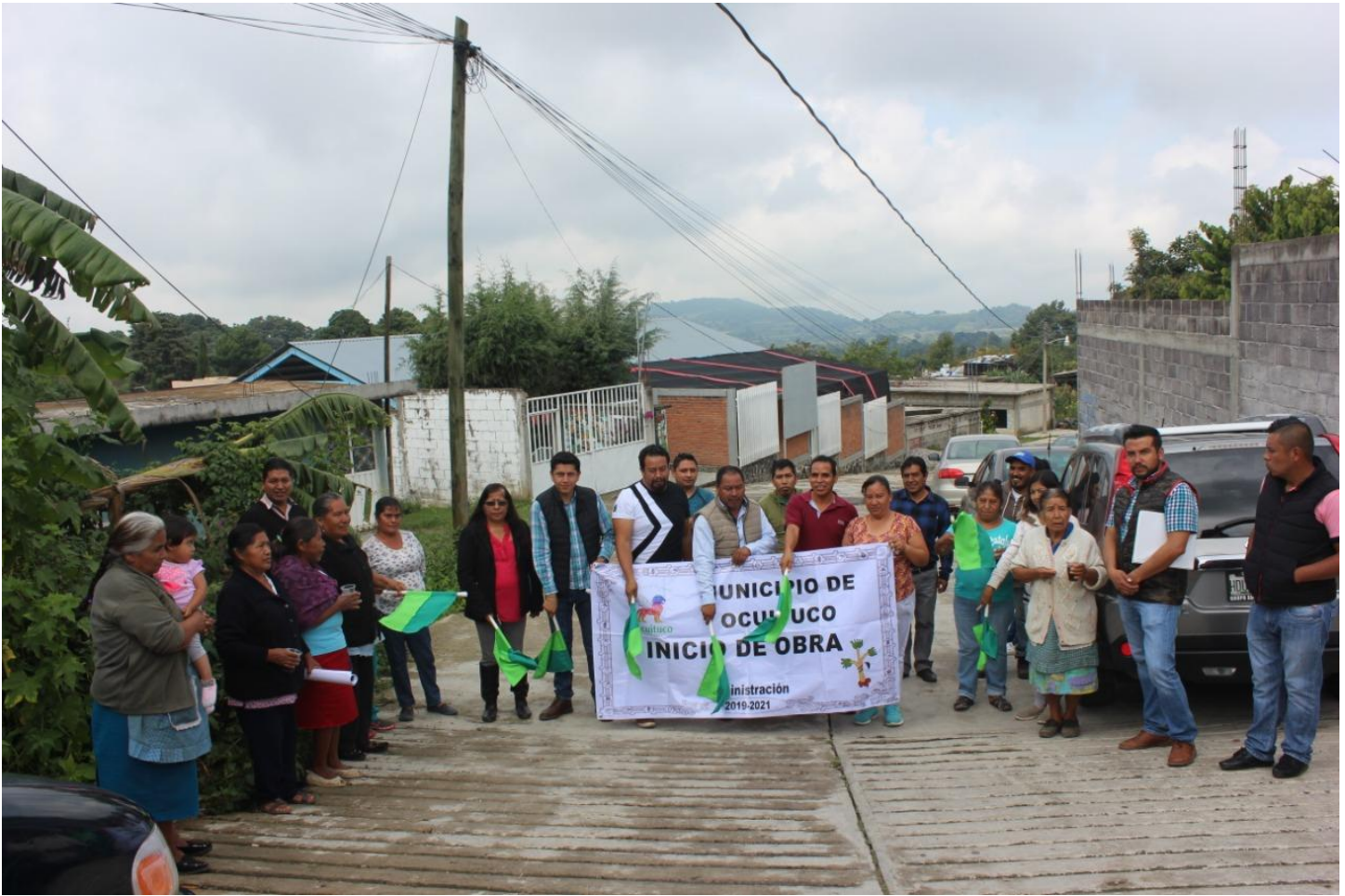
Ampliación de red eléctrica en calle Rinconada Manzanares y Reforma, en HUECAHUASCO
