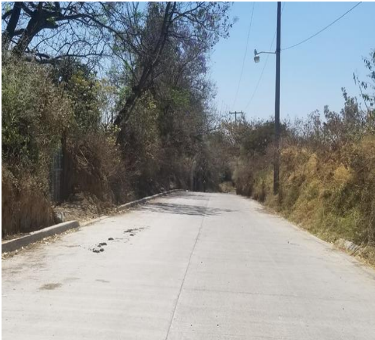
Pavimentación en la calle Tlacoatzingo 1era etapa, en la Cabecera Municipal de OCUITUCO
