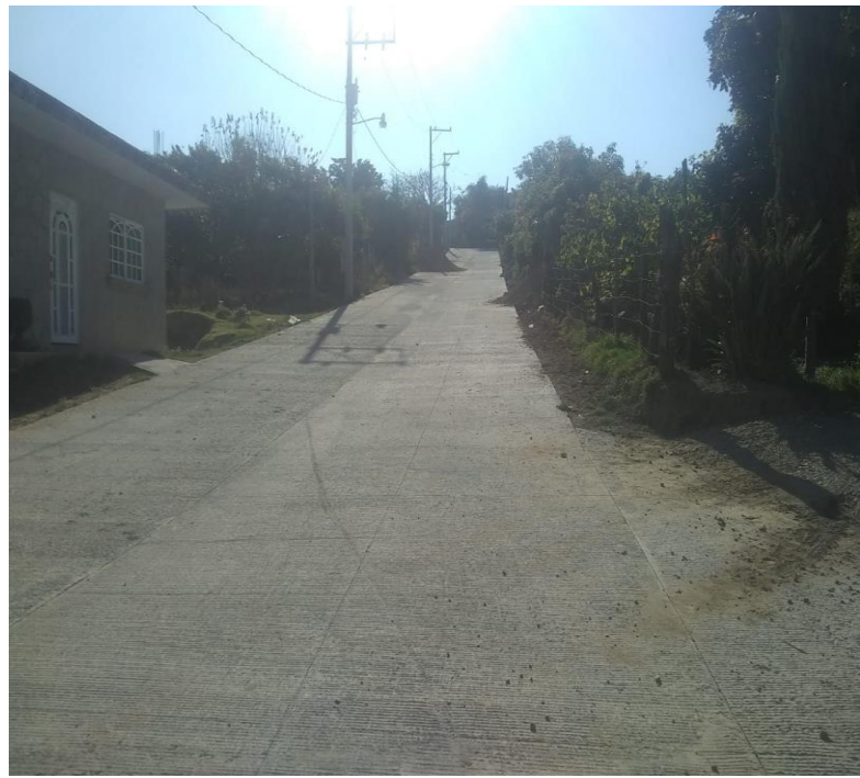
Pavimentación con concreto hidráulico de la calle 14 de febrero, de HUECAHUASCO,
