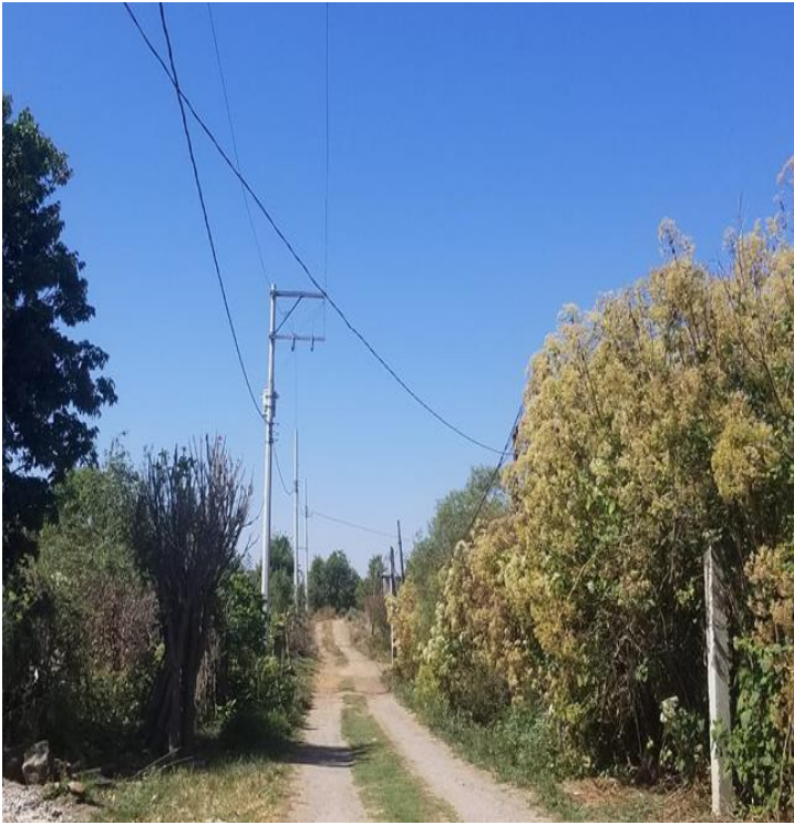
Ampliación de red eléctrica en calle Lauro Ortega, ubicada en la Comunidad de OCOXALTEPEC
