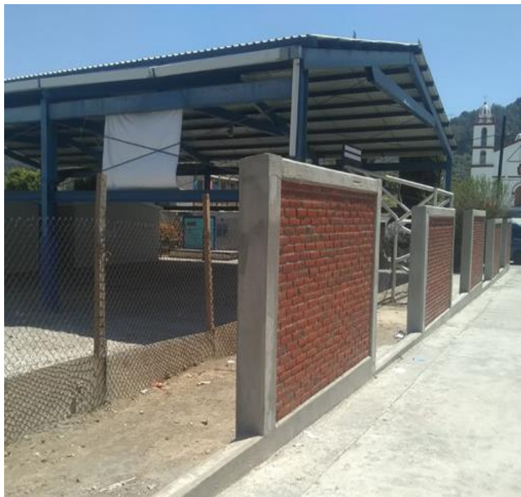
Construcción de barda perimetral en la Primaria Venustiano Carranza, de OCOXALTEPEC
