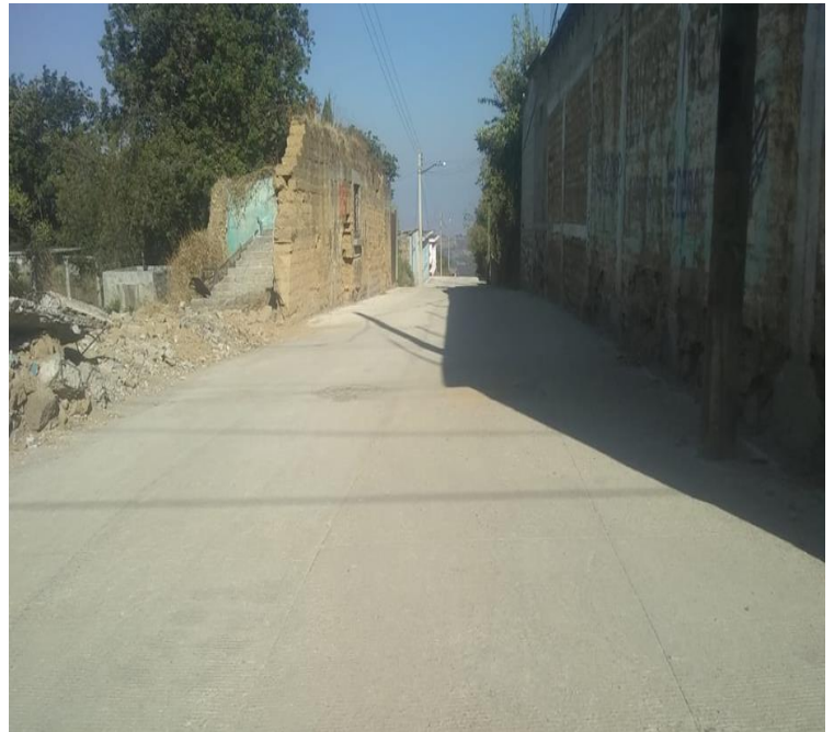
Pavimentación con concreto hidráulico de la calle cerrada Vicente Guerrero, en JUMILTEPEC
