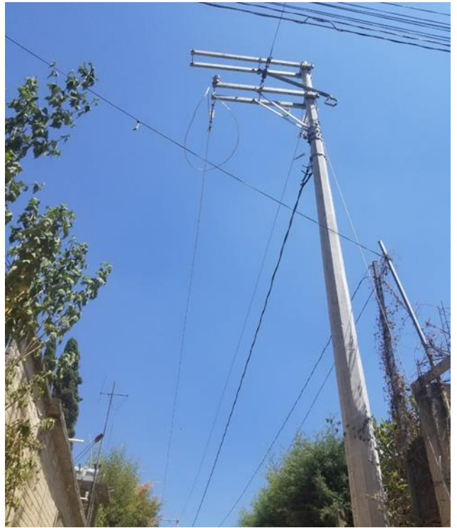
Ampliación de red eléctrica en calle la Viga, de la Comunidad de OCOXALTEPEC
