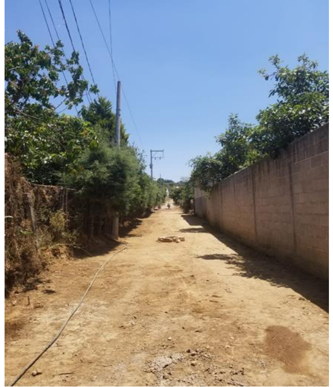
Ampliación de la red de drenaje sanitario en la calle Chignahuapan, en HUEJOTENGO
