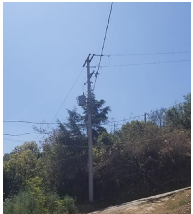
Ampliación de red eléctrica en calle Chichicalco, de la comunidad de HUECAHUASCO,
