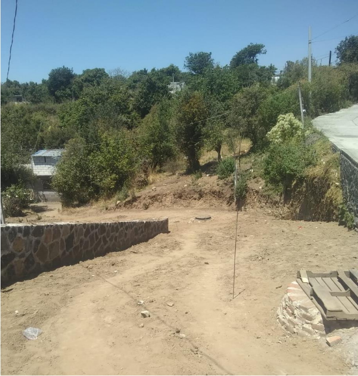
Ampliación de la red de drenaje sanitario en calle la Gloria, en OCOXALTEPEC
